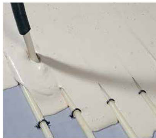
Το κονίαμα πλήρωσης δαπέδου FE60 Magic καλύπτει ιδανικά τις σωλίνες ενδοδαπέδιας θέρμανσης και μεταφέρει τη θερμότητα στην επιφάνεια το ταχύτερο δυνατό.
