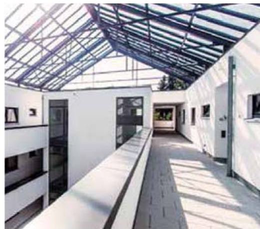
Τα μαλκόνια στο εσωτερικό αίθριο χρησιμεύουν ως δίοδοι διαφυγής από το κτίριο. Το σύστημα εξωτερικής μόνωσης Knauf Thermoprosopsis με πετροβάμβακα Energy Plus πάχους 140mm εξασφαλίζει την απαραίτητη πυροπροστασία σχεδιασμού.
