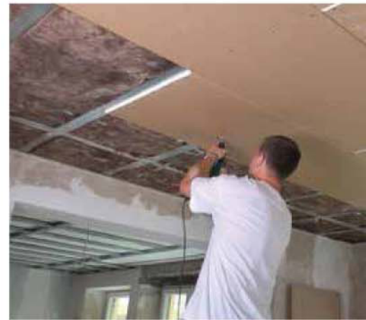
Η τεχνική ποιότητα ήχου των συστημάτων οροφής με Knauf Silentboard αυξάνεται με μια πρόσθετη στρώση από μονωτικά υλικά με τεχνολογία ECOSER® της Knauf Insulation.
