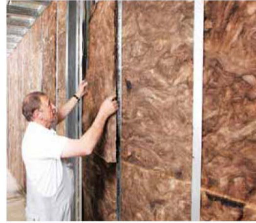
Οι κύριοι και δευτερεύοντες οδηγοί καλύπτονται με ορυκτοβάμβακα με τεχνολογία ECOSER® για να μειωθεί η μετάδοση του ήχου. Τα αποτελέσματα των μετρήσεων ήταν αισθητά καλύτερα από τα απαιτούμενα.
