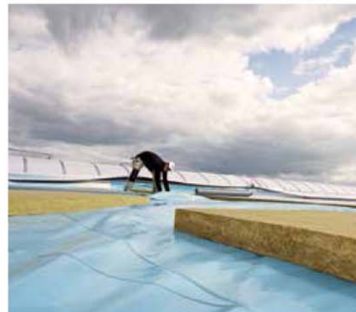
Τα μονωτικά υλικά της Knauf Insulation προστατεύουν τα κτίρια από θερμικές απώλειες διαμέσου των στοιχείων του κελύφους τους, όπως οι επίπεδες ταράτσες.
