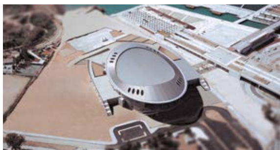
Στεγανοποίηση Οροφών & Δωμάτων
