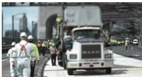
Επισκευή, Προστασία & Αποκατάσταση ΟΣ
