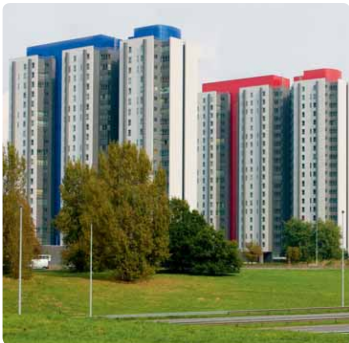
SILVERTOP, ΚΤΙΡΙΟ ΚΑΤΟΙΚΙΩΝ, ANTWERPEN, ΒΕΛΓΙΟ (ΦΩΤΟΓΡΑΦΙΑ: ETERNIT ΒΕΛΓΙΟ)
