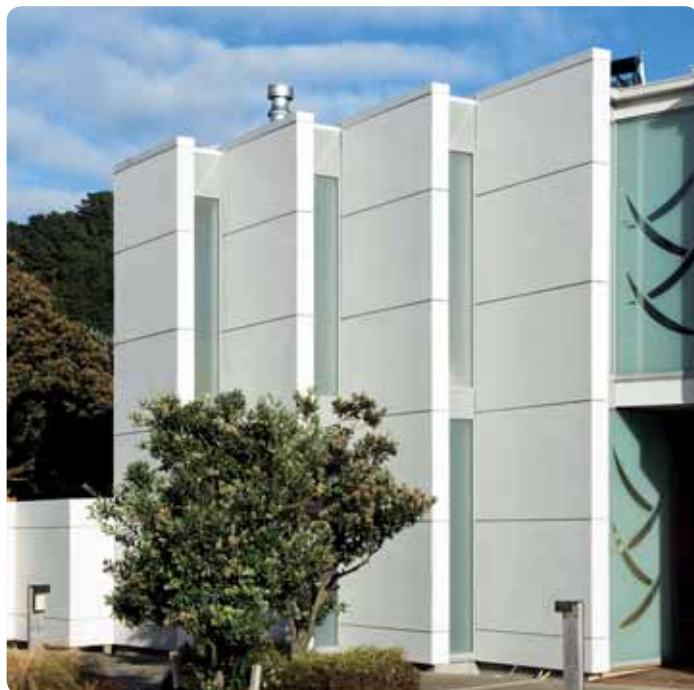
ΚΤΙΡΙΟ ΚΑΤΟΙΚΙΩΝ, ΝΕΑ ΖΗΛΑΝΔΙΑ (ΦΩΤΟΓΡΑΦΙΑ: EURO PANELS)
