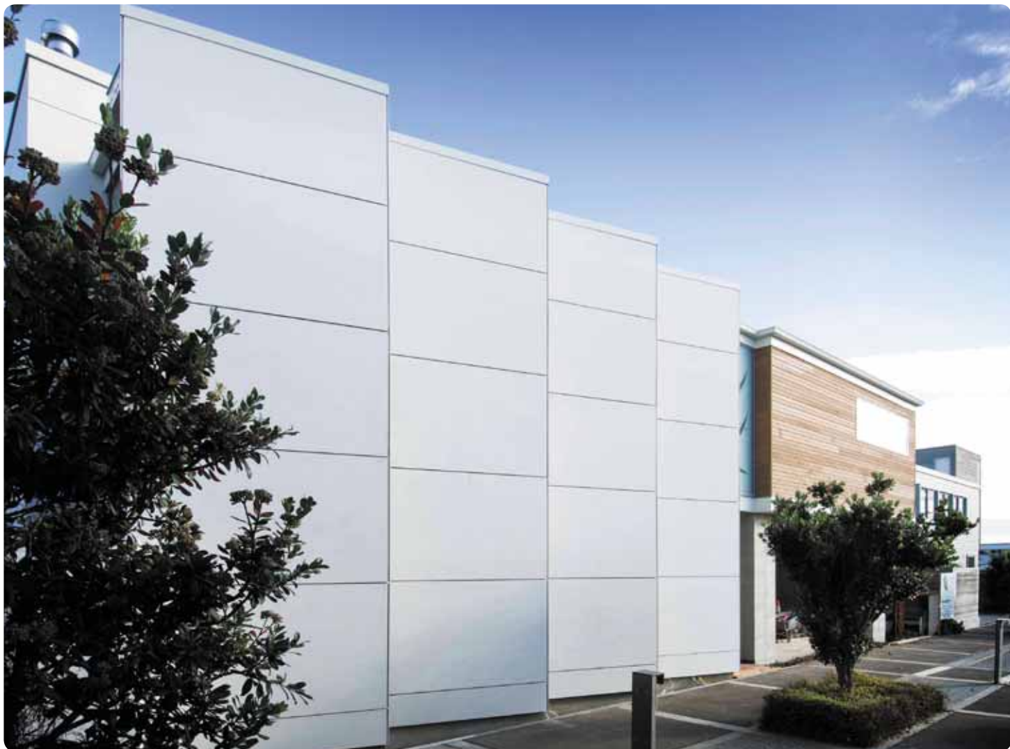
ΚΤΙΡΙΟ ΚΑΤΟΙΚΙΩΝ, ΝΕΑ ΖΗΛΑΝΔΙΑ (ΦΩΤΟΓΡΑΦΙΑ: EURO PANELS)
