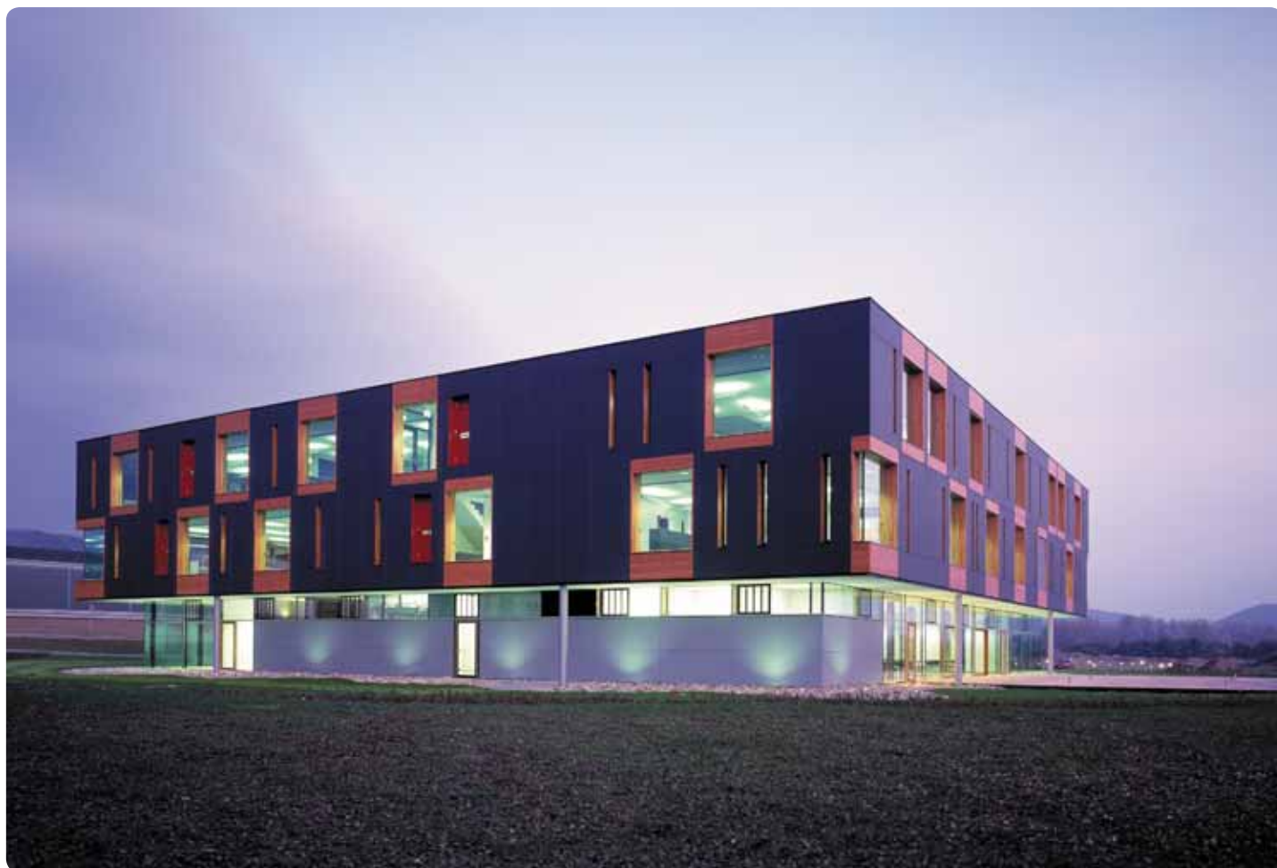
NATURA - ΚΤΙΡΙΟ ΓΡΑΦΕΙΩΝ, CREUZENBURG ΓΕΡΜΑΝΙΑ, SEELINGER VOGELS ARCHITECT
